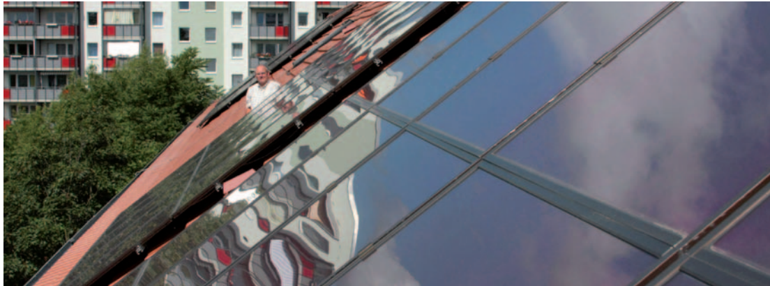
Karl-Heinz Schulze, Bürgersolaranlage auf dem Dach des Brecht-Gymnasiums.
