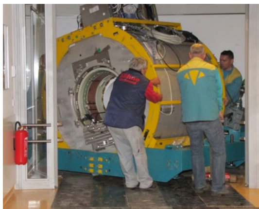
Einbringung des neuen MRTs (3-Tesla), Inbetriebnahme Ende Mai 2010.
