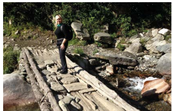
Der Weg über eine Brücke.
